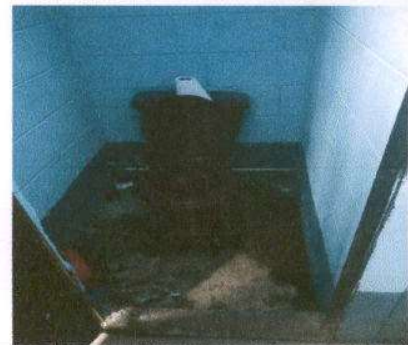
Foto 6: Sustrucción de inodoro por mingitorio
