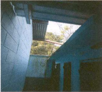
Foto1: Sustrucción de lamina, por lamina troquelada aluzinc calibre 26
