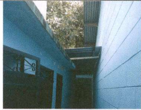
Foto 2: Sustrucción de estructura de soporte de metal por metal.
