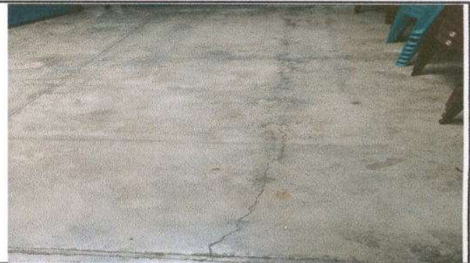
Foto 4: Sustrucción de piso de cemento liquido por cerámico.
